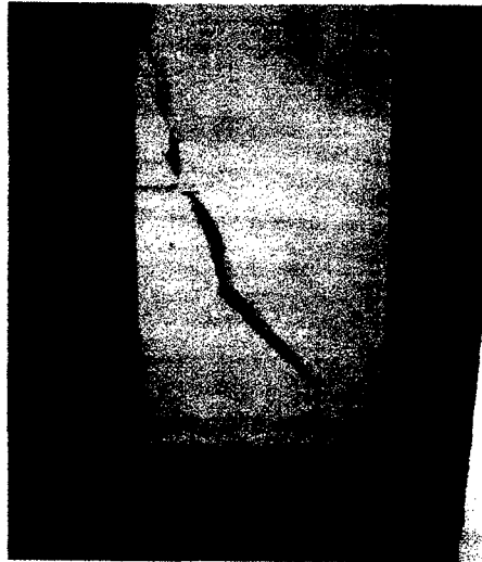
Fotografía1: Falla tabique no estructural
